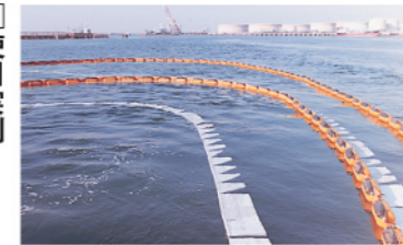
オイルフェンスを併用し油を回収
